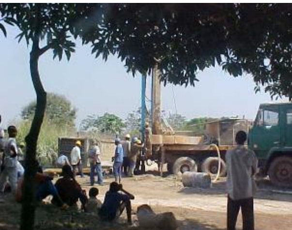
Große Maschinen kommen bei der Bohrung eines Tiefbohrbrunnens zum Einsatz.
