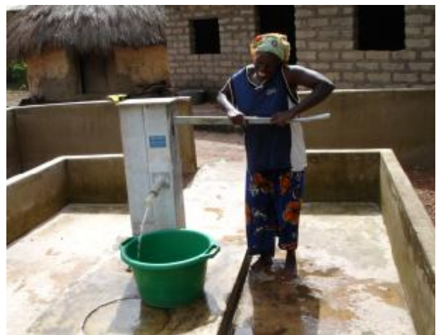
Der Tiefbohrbrunnen ist durch eine Umzäunung vor Tieren geschützt.
